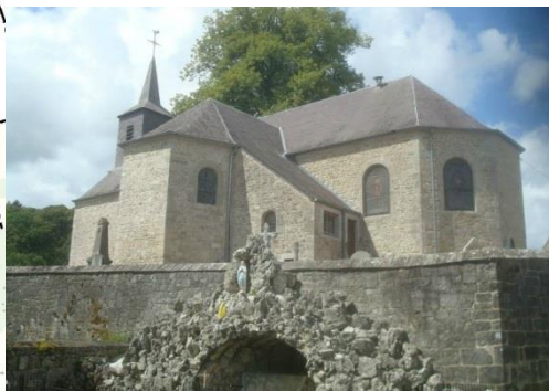
L'église Saint-Servais à Dourbes (M) ainsi que l'ensemble formé par ladite église, le cimetière qui l'entoure et son mur de clôture (S)
