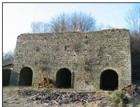
Figure 38: Four à chaux de Treignes (Photo: SPAQuE)
