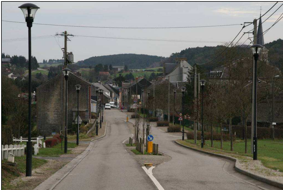
Figure 33 : Porte entrée village (ouest) à Treignes (Photo : AWP+E)
