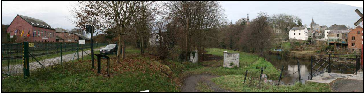
Figure 29 : mesure AO-05 : espace de rencontre à Vierves – terrain privé situé sur la rive droite du Viroin, en amont du pont.
