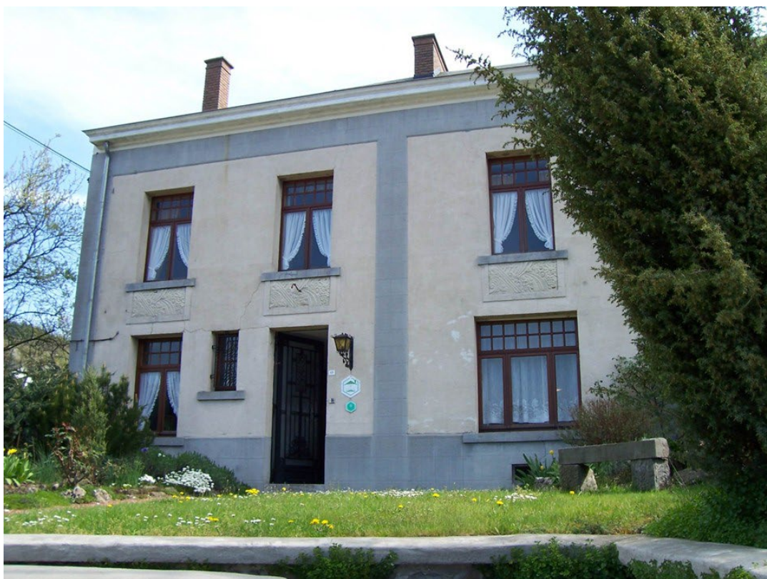
Façade avant du gîte vue de la Rue des Eglises.
